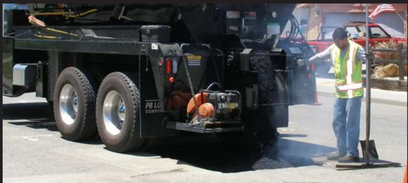
Add asphalt mix.
