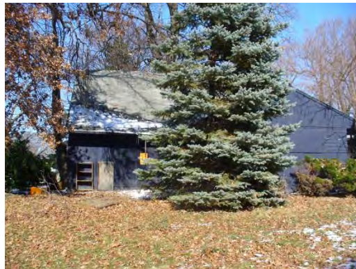
874 E WEBER RD 010-072513
