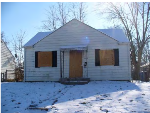
1235 E WEBER RD 010-079733
